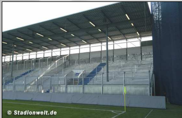
Negativbeispiel: 2 m hohe Blocktrennung in Wiesbaden.
