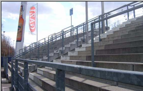
Steile Stehstufen und wenige Wellenbrecher im Stuttgarter Gazi Stadion
