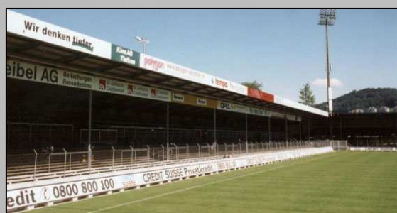
Choreografie und weit vorn liegende Dachstützen im Stadion Espenmoos St Gallen/Schweiz
